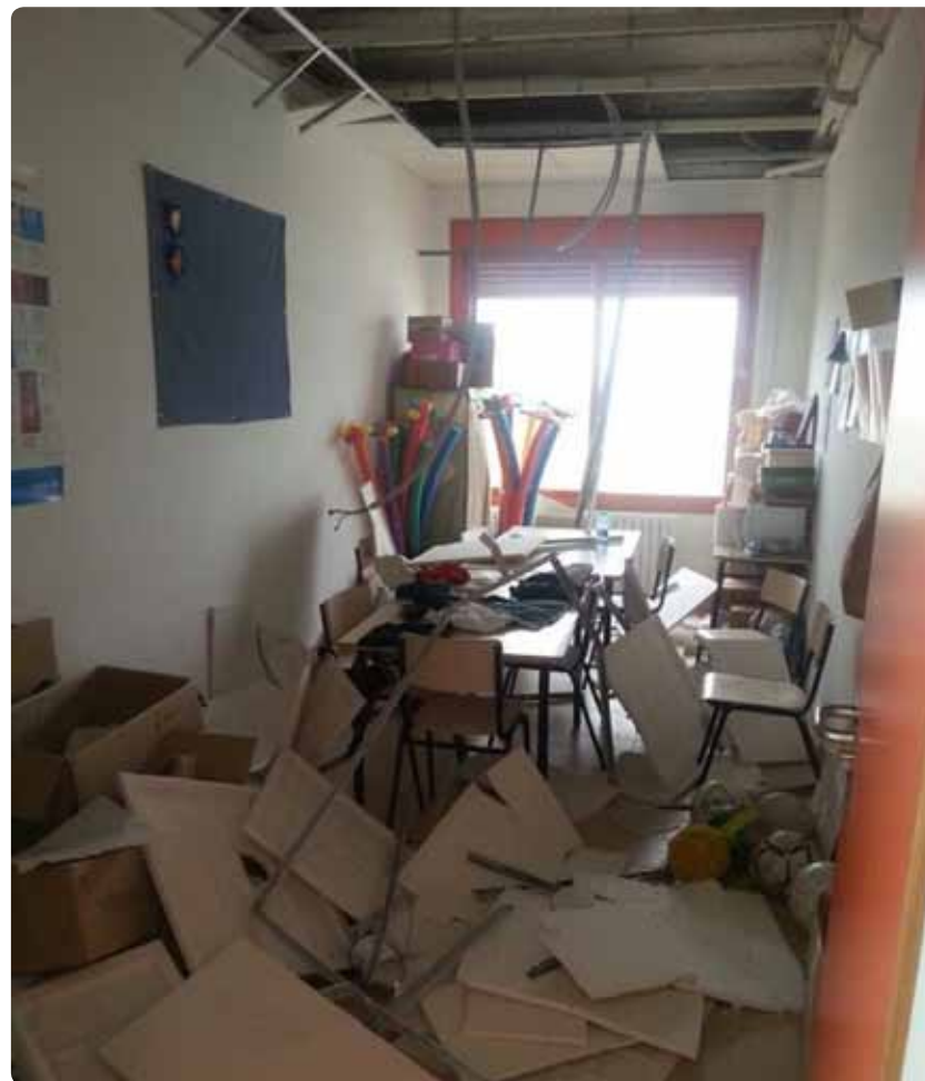
Al febrer de 2013 es va produir la caiguda de tot el sostre de l'aula destinada a l'AMPA del CEIP La Pea. Malgrat que en el seu interior hi havia persones no va caldre lamentar desgràcies personals. Com és possible que passe açò en un centre amb menys de quatre anys al que acudeixen centenars d'escolars diàriament?
